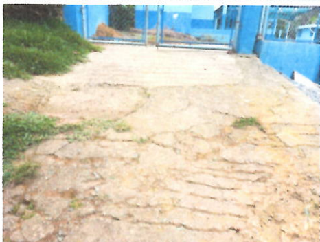
Foto 3: Reparación de losa de concreto para patios, considerando preparación de terreno, armado, nivelación y acabado rustico, en ingreso principal, en la parte posterior y lateral del establecimiento .
