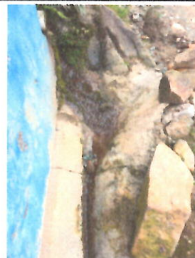
Foto 4: Reparación de canales de concreto para conducción superficial de agua pluvial, con pendiente, refuerzo y para protección de muro permietral en la parte externa.
