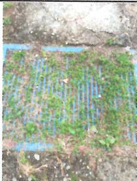
Foto 1: Reparación de canales de concreto para conducción superficial de agua pluvial, con pendiente, refuerzo y sustitución de rejilla metálica
